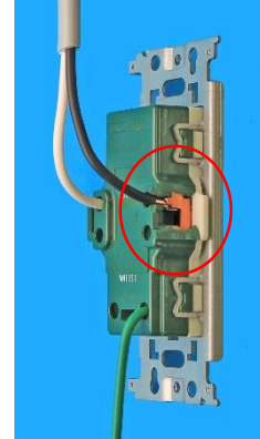
連用器具、埋込器具の破損
